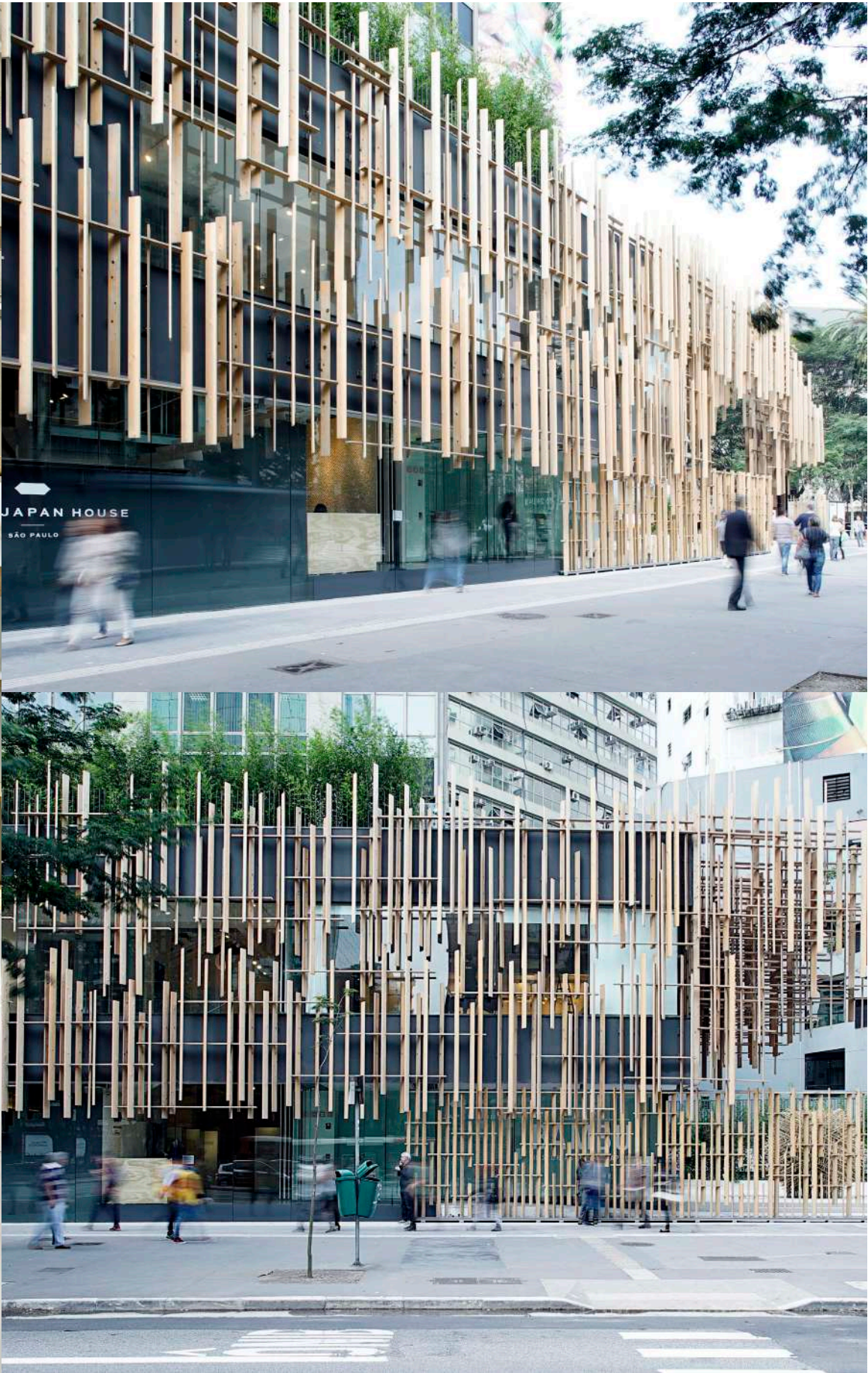
檜を「地獄組み」という木組みによって構成、 独特の外観が通りを行く人々の目を奪う。 日本から宮大工を動員して完成したもの。
